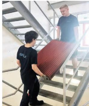
*Enge Durchgänge sind für die Einbringung der GSWT®-Module kein Problem.*
