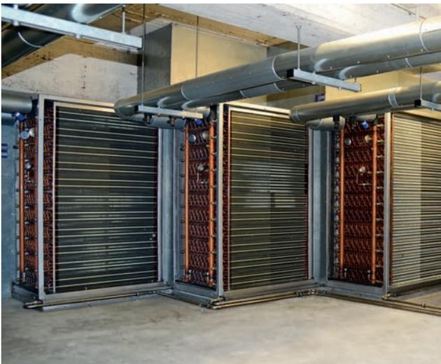
*Eingebauter Außenluft-GSWT® im gemauerten Kanal, die Anpassung an jede Aufstellfläche ist möglich.*
